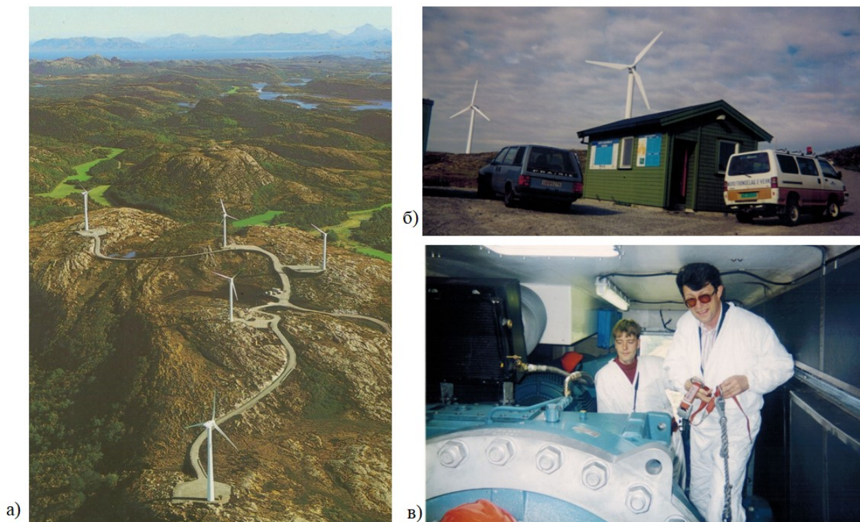
Рис. 16. Ветропарк «Викна» в Норвегии: a — общий вид; b — подъезд к ветропарку; в — проведение наладочных работ внутри гондолы ВЭУ, расположенной на высоте около 40 м
