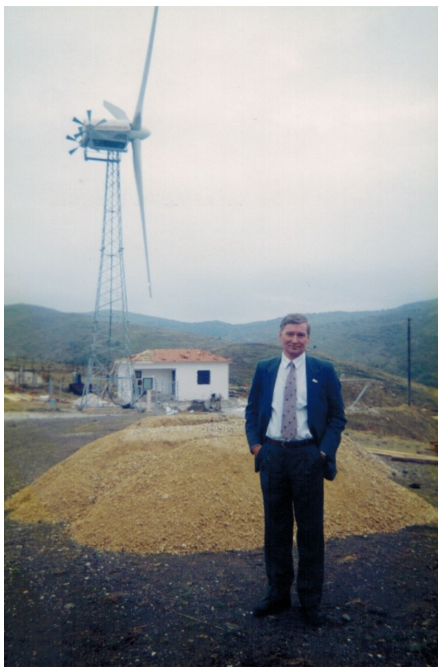
Рис. 14. Комбинированная ветродизельная электростанция на о. Айос-Эфстратиос, Греция Fig. 14. A wind-diesel hybrid power plant on the island of Agios Efstratios, Greece
