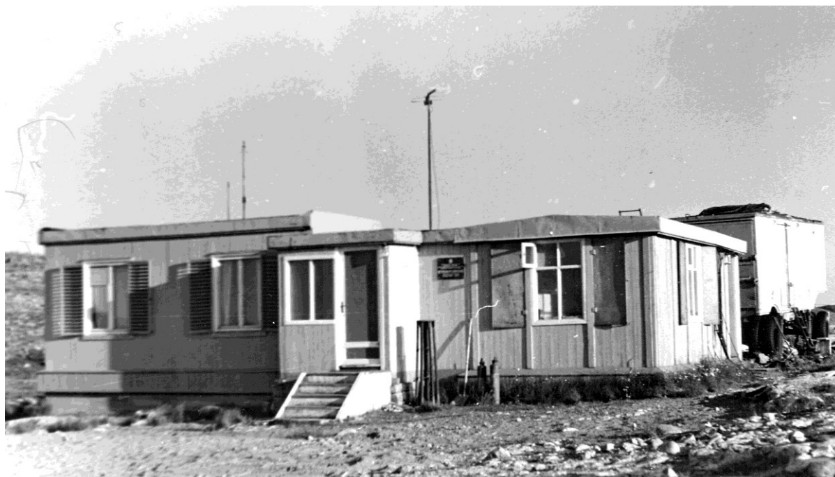
Рис. 2. Вспомогательные помещения полигона: слева — жилое помещение для обслуживающего персонала, справа — помещение для приборов и контрольного оборудования, сзади — помещение для выполнения слесарных и ремонтных работ
