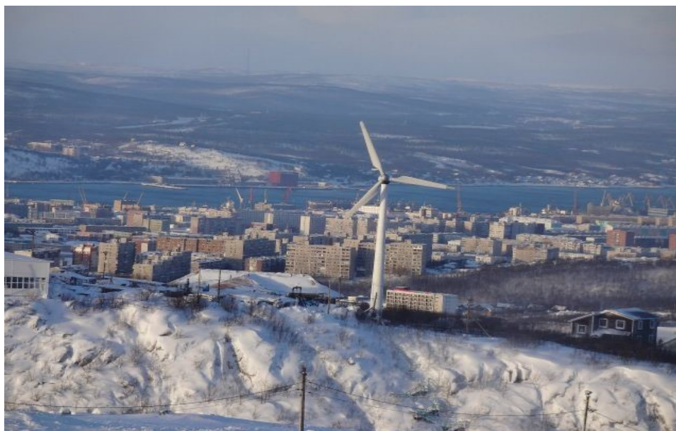
Рис. 15. Сетевая ветроэнергетическая установка Wincon-200 мощностью 200 кВт вблизи г. Мурманска, введенная в эксплуатацию в 2001 г.
